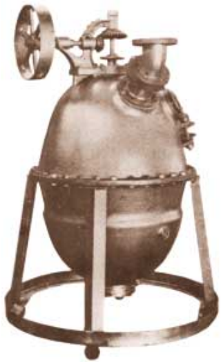
Erster Reaktor zur Herstellung von Kunstharzen von Leo Hendrik Baekeland
